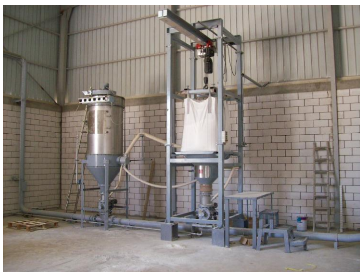
Système de transport pneumatique incluant une station de vidange de big bags et un filtre de récupération et de réintroduction des fines dans le circuit (station propre)
